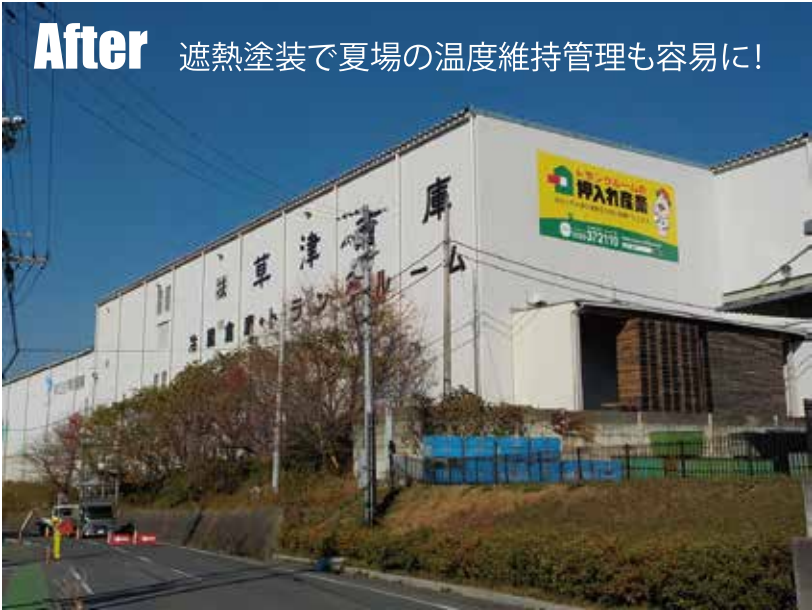
※ 定温(20度)の倉庫です。既設の設備でどれだけ冷やしても定温まで下がらなかった室温が、遮熱塗装で下がった事例。
