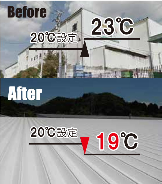
※ 定温(20度)の倉庫です。既設の設備でどれだけ冷やしても定温まで下がらなかった室温が、遮熱塗装で下がった事例。
